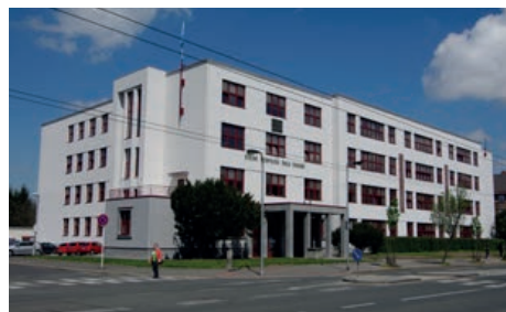
Výměna vnějších výplní otvorů na hlavní budově SPŠ stavební, Hradec Králové, Pospíšilova tř. 787
