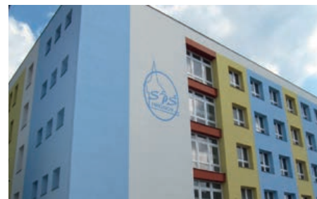
Zateplení budovy SPŠ Hronov, Hostovského 990
