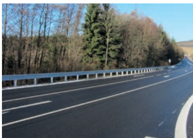
Zrekonstruovaná silnice Dolní Branná – Vrchlabí
