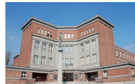
Stavební úpravy objektu Gymnázia J.K.Tyla
