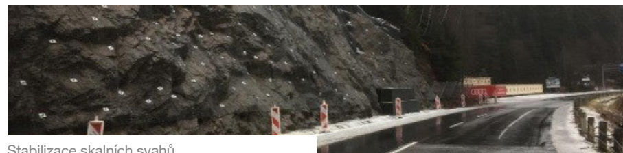
Stabilizace skalních svahů
