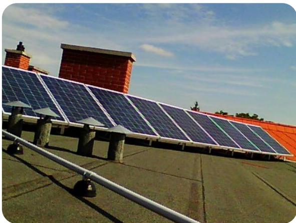
▲ Kontrola provozu fotovoltaické elektrárny
