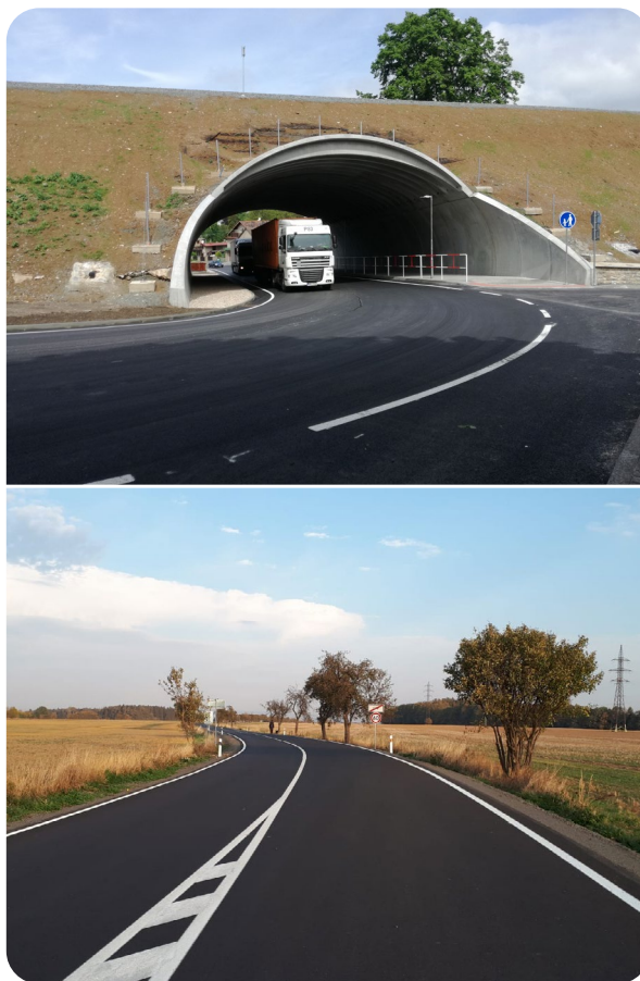
▲ Rekonstrukce vozovky III/30821 (Spy – Nové Město n. Metují)
