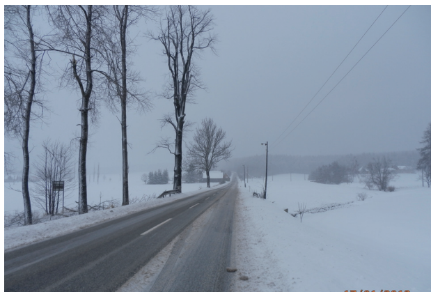
Komunikaci na vrchol Pasa čeká rekonstrukce a rozšíření o stoupací pruhy
