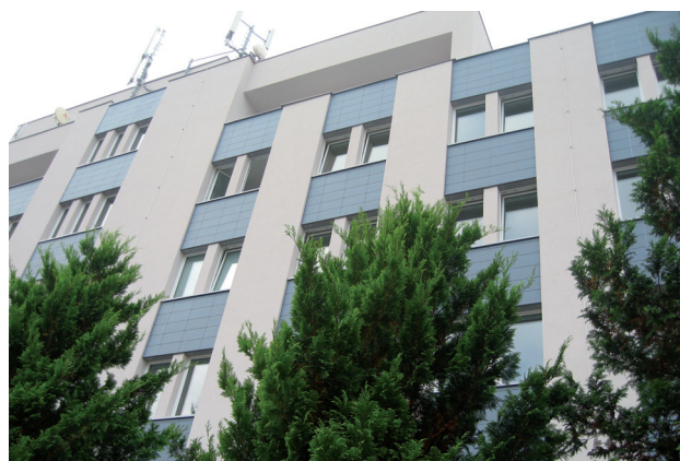
Zateplení oblastní nemocnice Trutnov
