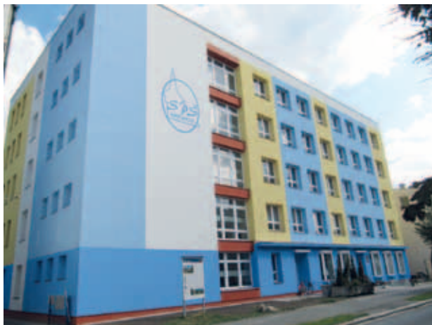
Zateplení budovy SPŠ Hronov
