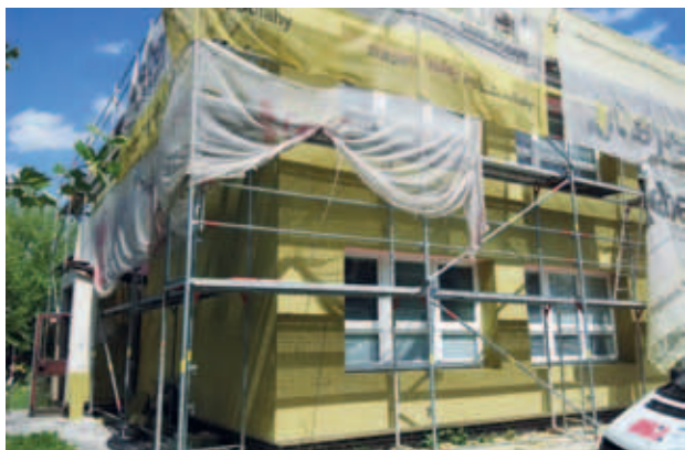
Zateplení LDN – B nemocnice Nový Bydžov
