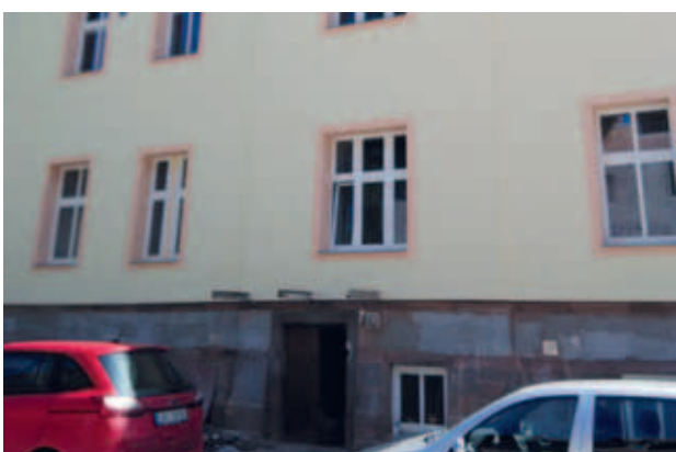
Zateplení Domova mládeže (Dolní Lánov)
