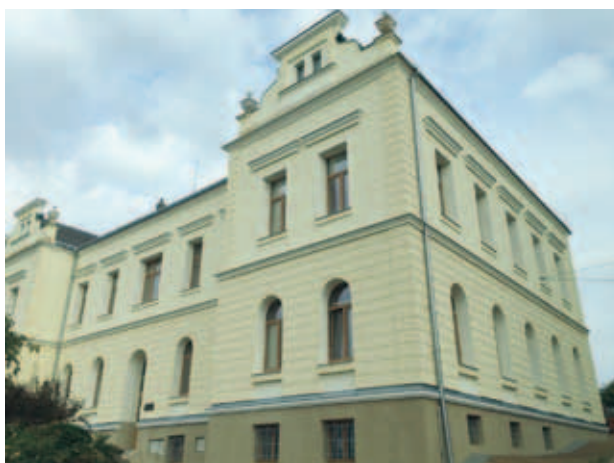
Zateplení objektu školy Riegrova
