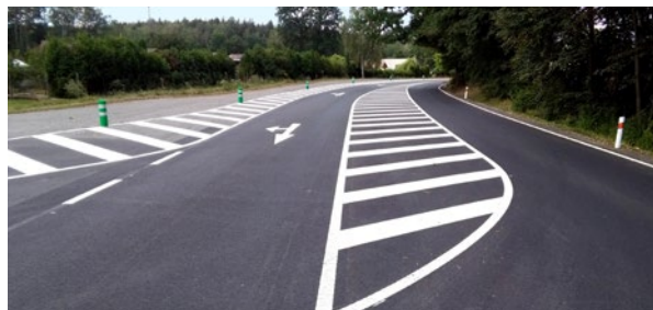
II/305 Albrechtice nad Orlicí – Borohrádek (stav po realizaci)
