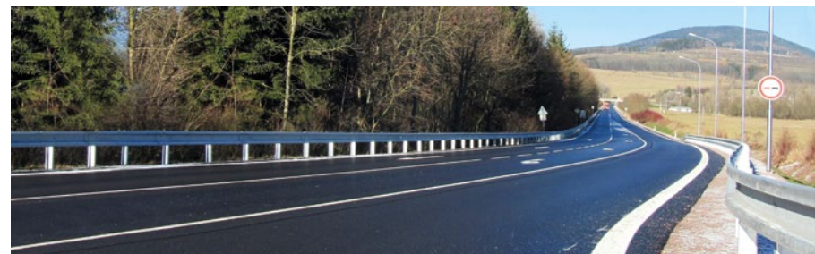
Zrekonstruovaná silnice Dolní Branná – Vrchlabí
