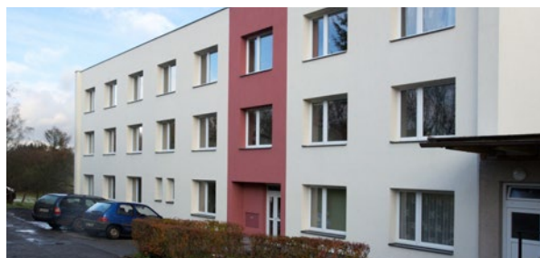
Zateplení domova mládeže SŠOS Červený Kostelec
