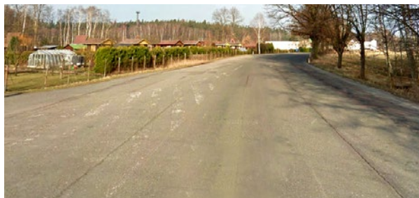
II/305 Albrechtice nad Orlicí – Borohrádek (stav před realizací)
