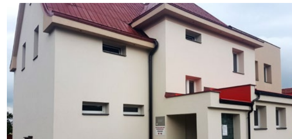
Zateplení budovy výjezdového stanoviště Jaroměř
