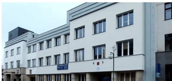
Zateplení fasády a střechy budovy školy SŠGS v Nové Pace
