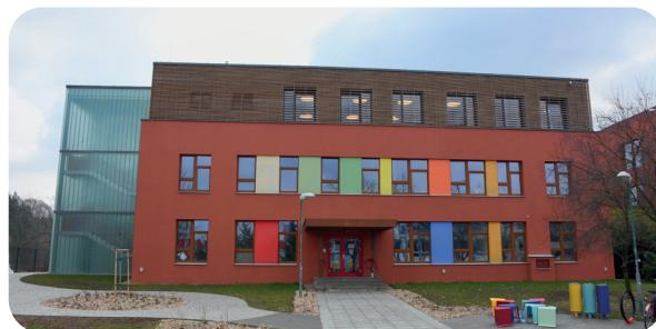
▲ Nástavba CKOP na VOŠ, SŠ, ZŠ a MŠ Štefánikova
