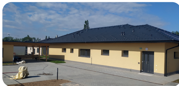
▲ Nově vybudované zázemí v Třebechovicích pod Orebem
