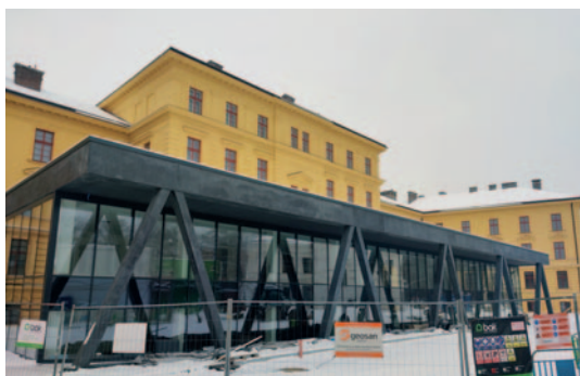
SMARTmuzeum – průběh rekonstrukce,
