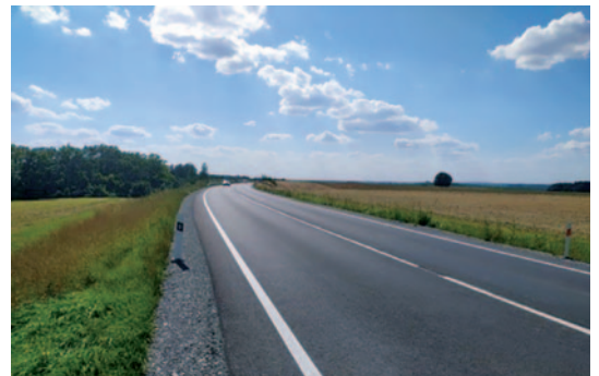
Nová vozovka III/30821
