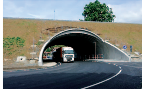
Nová vozovka III/30821
