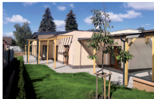
Nově vybudovaného zázemí v Kostelci nad Orlicí
