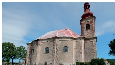
Stávající stav kostela sv. Anny ve Vižňově
