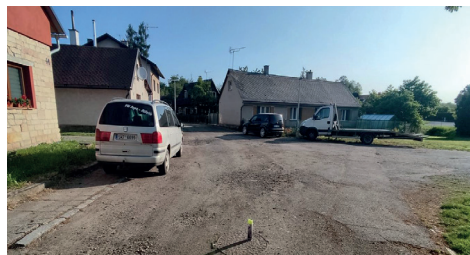
Miletín – stav před realizací rekonstrukce místní komunikace
