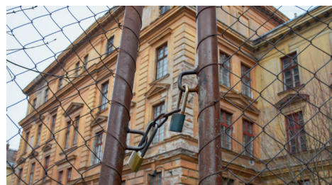
Vrbenského kasárna - stav před rekonstrukcí
