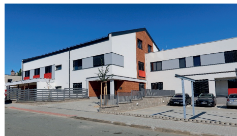
Nově vybudovaného zázemí v Roudničce
