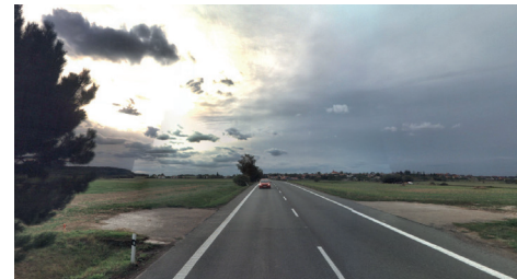
Stav před výstavbou nové cyklostezky
