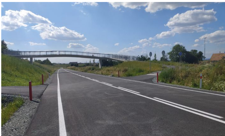
Obr. 6 Přeložka komunikace II/298 (směr PZ Opočno), I. etapa
